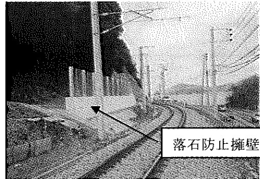
【落石防止擁壁の一例】
