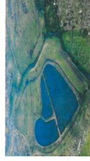
↑遊水地として治水機能を確保すると共に、水質改善や生態系保全にも寄与(渡良瀬遊水地)
