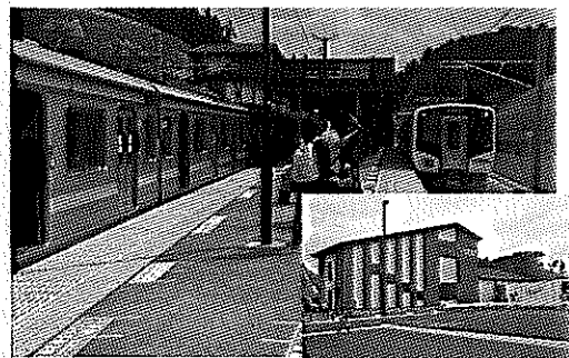
仙石線 復旧後:野蒜駅
