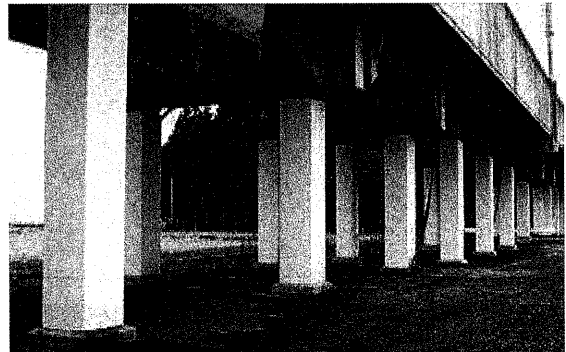
鋼板巻きによる高架橋の耐震対策
