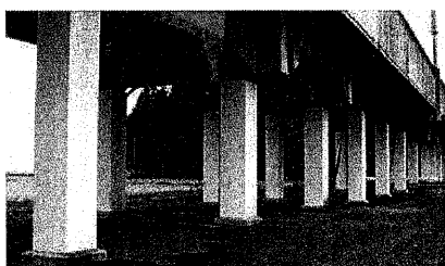
鋼板巻きによる高架橋の耐震対策
