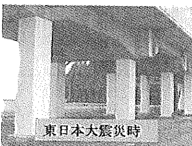
【高架橋の補強】
