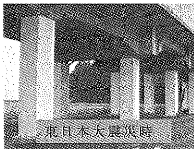
【高架橋の補強】
