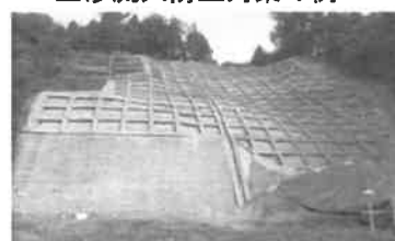
斜面の補強
