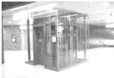
エレベーター
