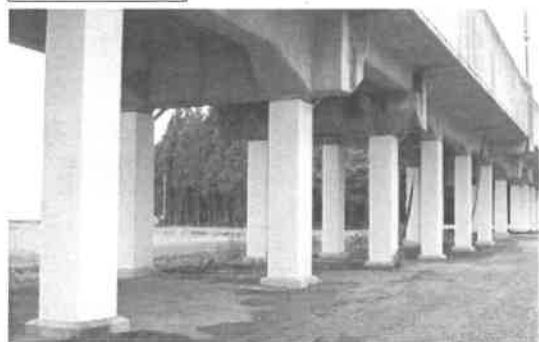
鋼板巻きによる高架橋の耐震補強
