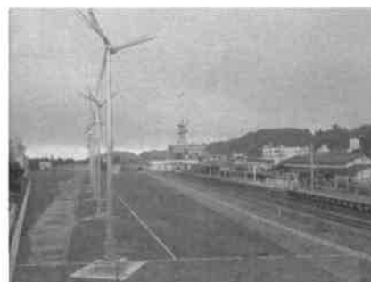
鉄道駅構内における風力発電
