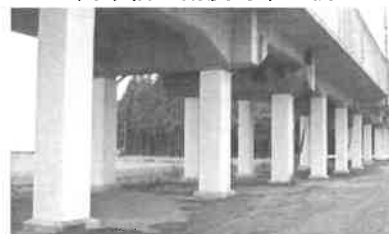
鋼板巻きによる 高架橋の耐震補強
