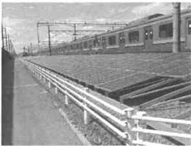
車両センター構内における太陽光発電
