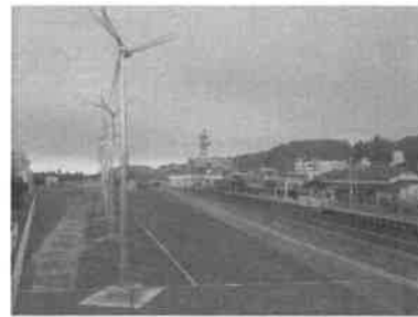
鉄道駅構内における風力発電
