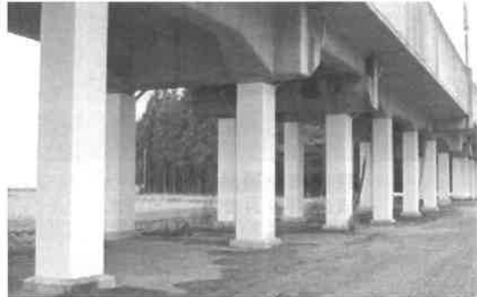
鋼板巻きによる高架橋の耐震補強
