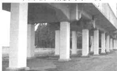
鋼板巻きによる 高架橋の耐震補強
