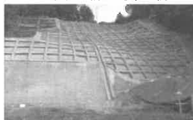
斜面の補強
