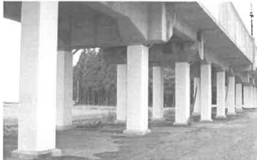
鋼板巻きによる高架橋の耐震対策
