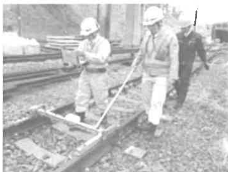
軌道変位計測の様子
