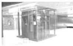
エレベーター
