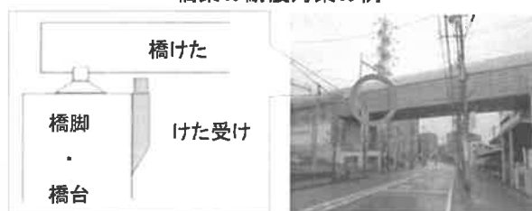
落橋防止工による橋梁の耐震対策
