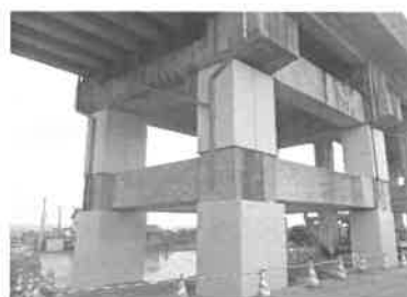
鋼板巻きによるラーメン橋台の耐震対策
