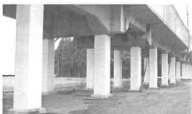
鋼板巻きによる高架橋の耐震対策
