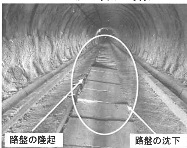
トンネル（先進導坑）の変状
