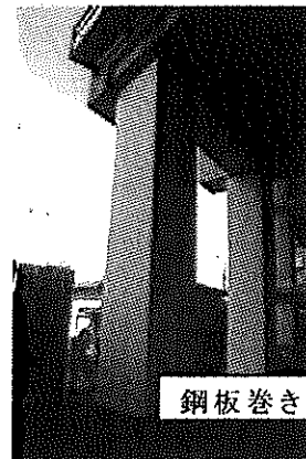
【高架橋の補強】
