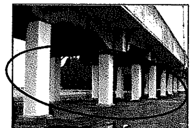
鋼板を巻く耐震補強により倒壊の被害なし
