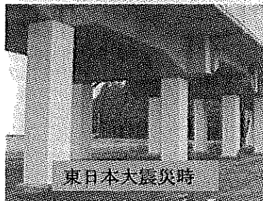
【高架橋の補強】
