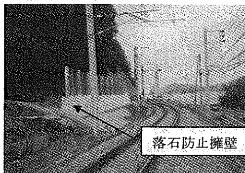
【落石防止擁壁の一例】
