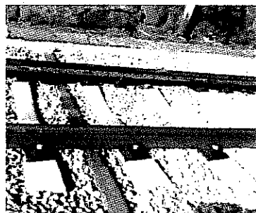
線路設備 (軌道改良(PCまくら木化))
