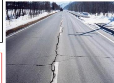
凍上災害による舗装の損傷事例
