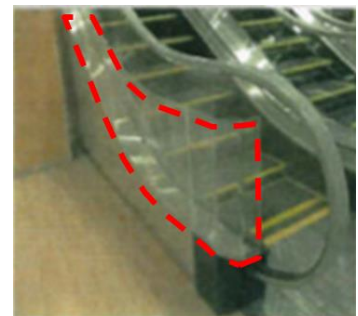
駆上り防止板の設置
