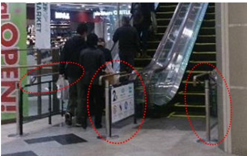
誘導手すりの設置
