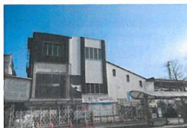
駅舎の改良（鶴巻温泉駅）
