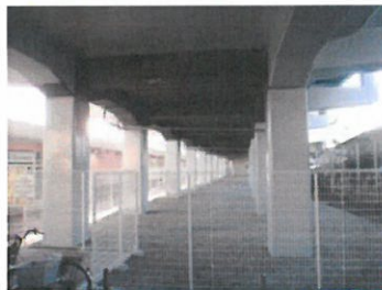
耐震補強工事（高架橋）※イメージ
