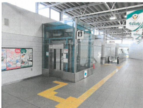
《①飛田給駅現行エレベーター》
