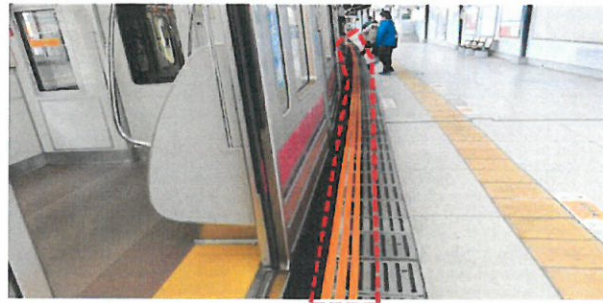
《注意喚起ライン（施工例：京王稲田堤駅）》
