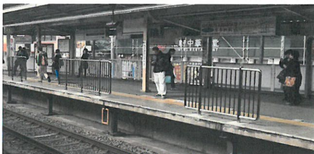
《転落防止固定柵（設置例：千歳烏山駅）》
