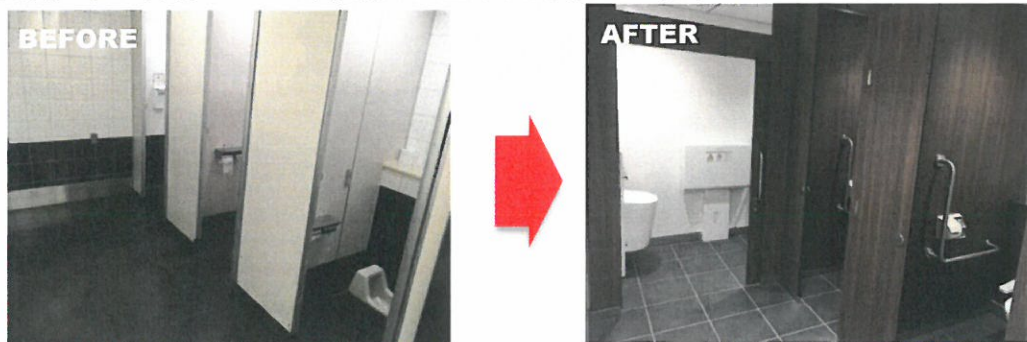
▲成田空港駅トイレのリニューアル
