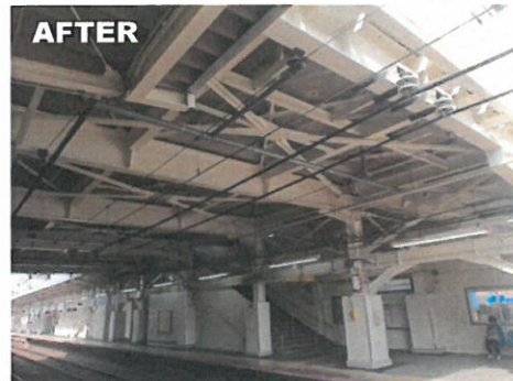
▲お花茶屋駅 耐震補強工事の様子
