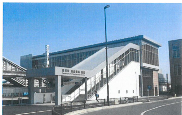
△高柳駅（工事中）
