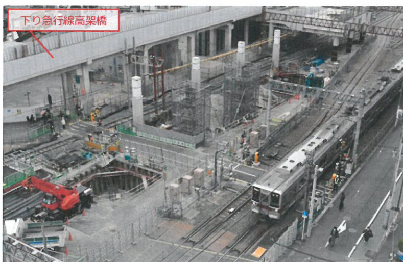
△竹ノ塚駅付近の高架橋(工事中)
