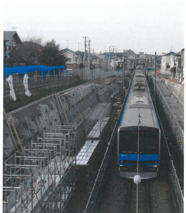
△六実～逆井間複線化（工事中）
