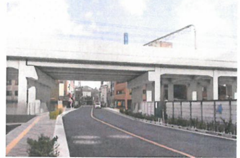
△とうきょうスカイツリー駅付近の高架橋（イメージ）
