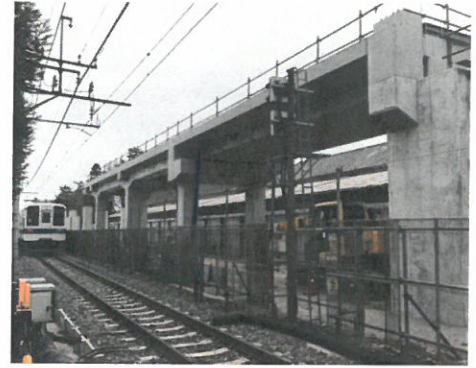
△清水公園～梅郷間の高架橋（工事中）
