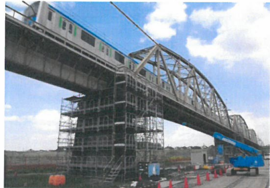
△江戸川橋梁の耐震補強（南桜井～川間）（工事中）
