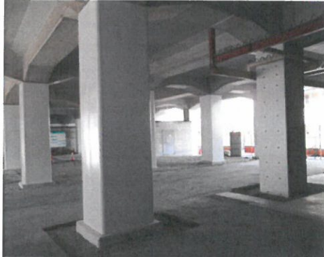
△高架橋耐震補強後（草加駅付近）
