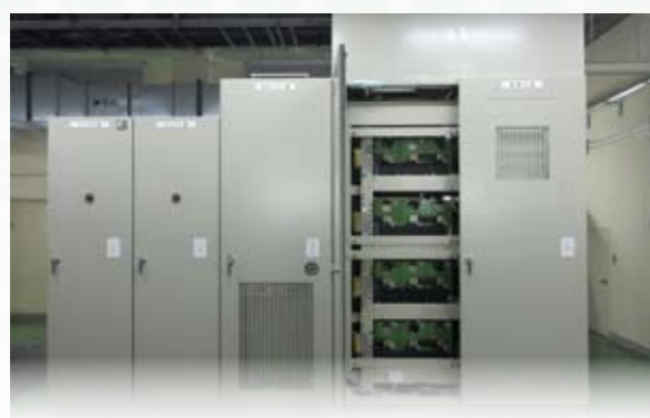
回生電力貯蔵装置 (札幌)
