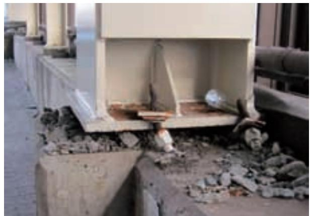
写真4 八乙女駅の上屋支柱を固定しているアンカーボルトの破断状況
