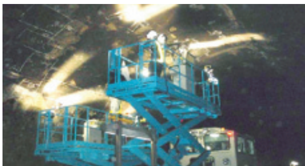
図-2 アーチ型トンネルでの検査状況
