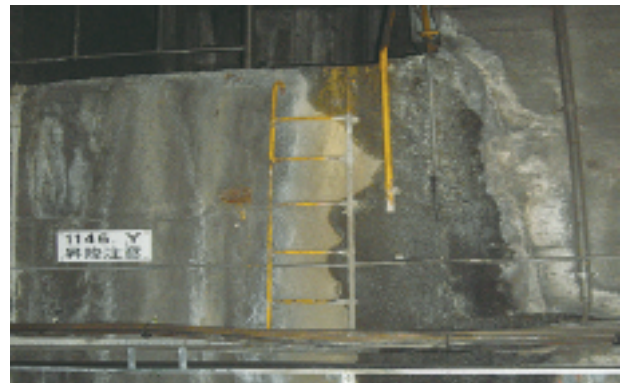
写真2 通風口の排水不良
