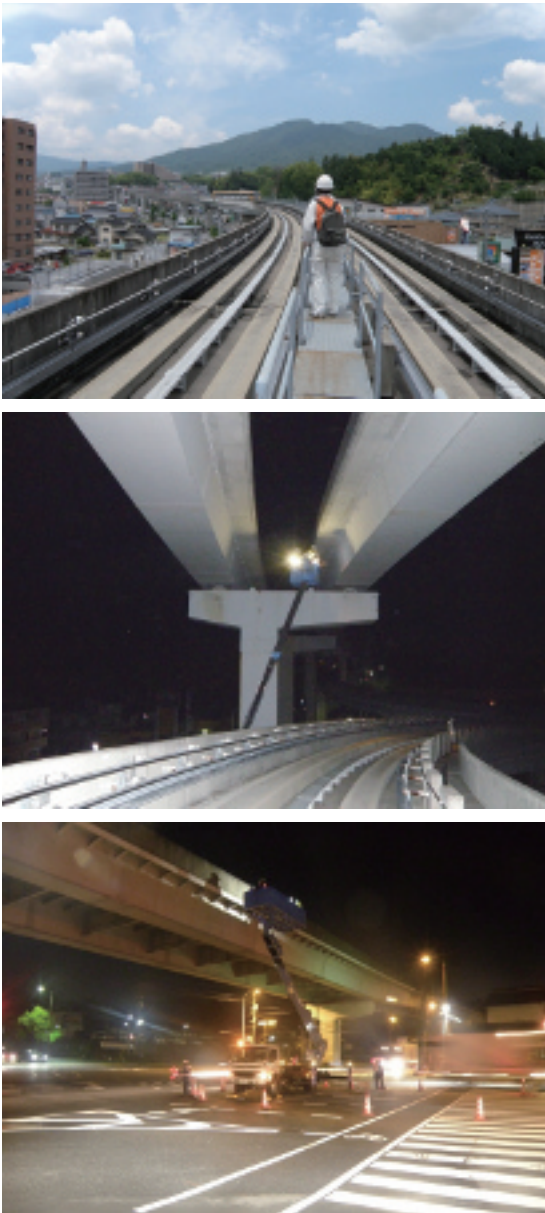
写真2 高架橋の近接点検実施状況
