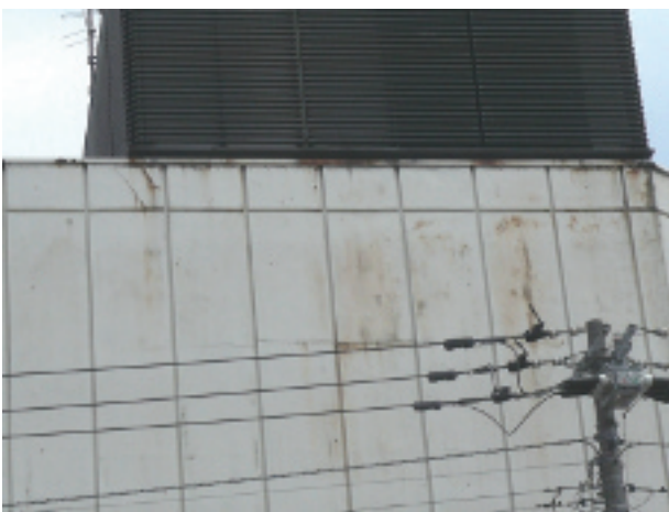
写真3 西28丁目駅外壁
