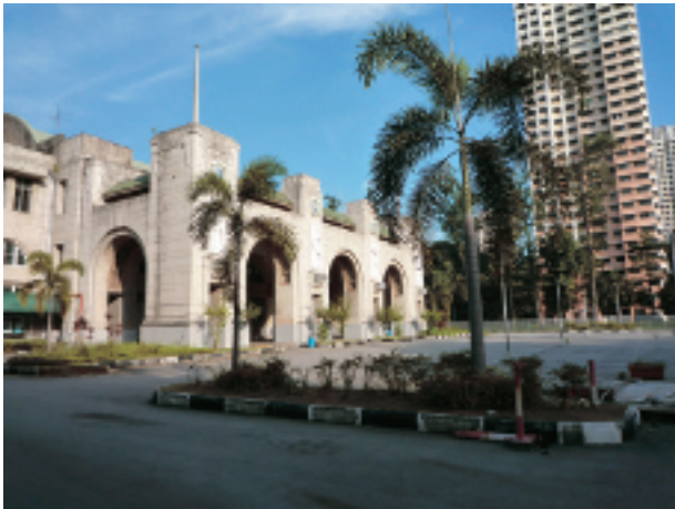
写真-4 KTMBの旧シンガポール（タンジョン=パガー）駅。現在、土地はシンガポールに返却され、周囲はフェンスで囲われている。（北西を見る。2011年11月19日）
