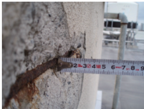
写真 1 南郷変電所外壁
