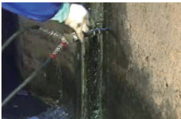
写真4 バンデフレキシシ工法の施工状況
