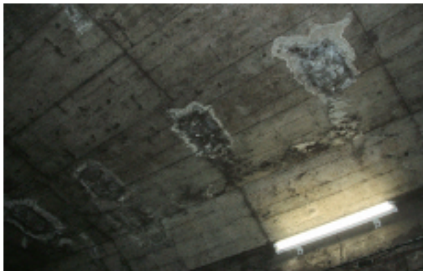
写真5 中間杭の跡埋め箇所
