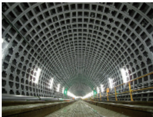
写真4 シールドトンネル
