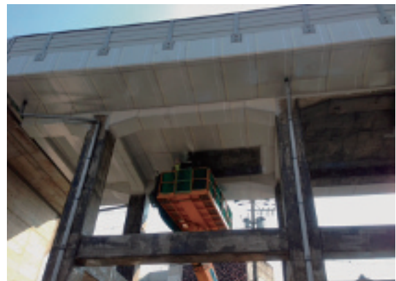
高架橋における予防補修工事状況
