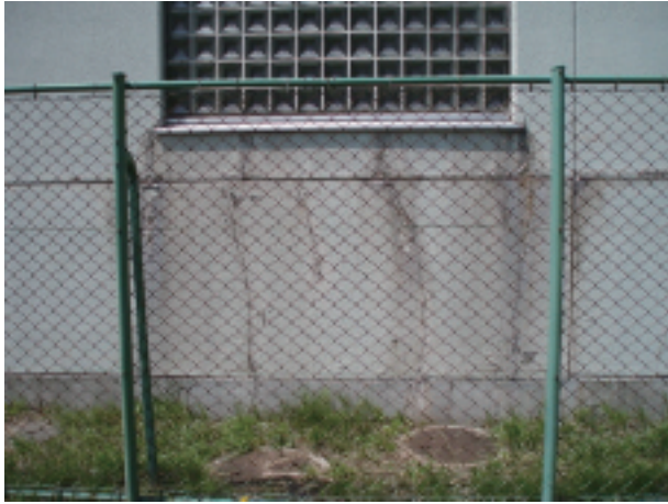
写真2 大谷地変電所外壁
