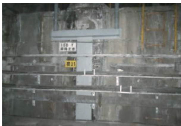
写真6 排水対策施工後
