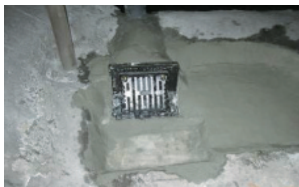
写真7 通風口内の集水部
