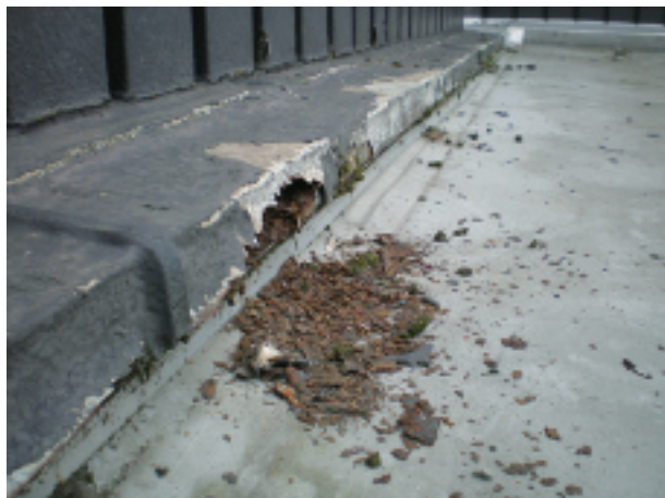
写真7 南車両基地屋上の外壁
