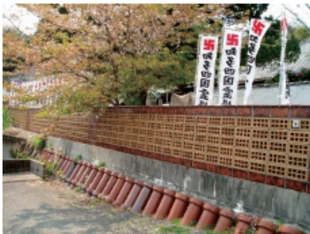
大善院（第63番）の壁面・土管
