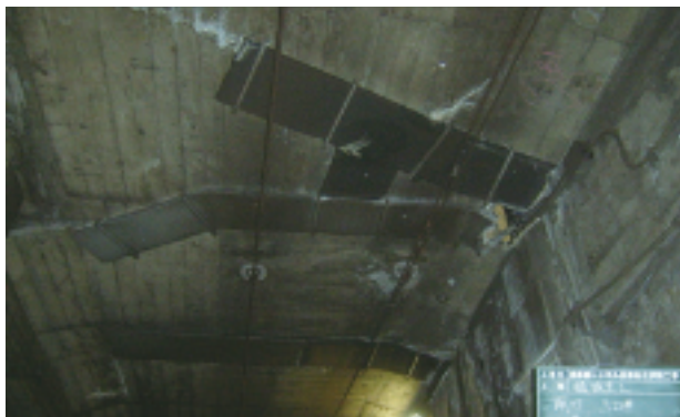
写真3 樋掛けの状況
