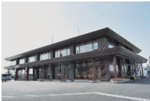
写真12 大涌谷新駅舎
