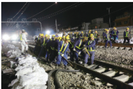
写真5 22日終電後の工事の様子
