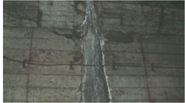
写真1 亀裂からの漏水
