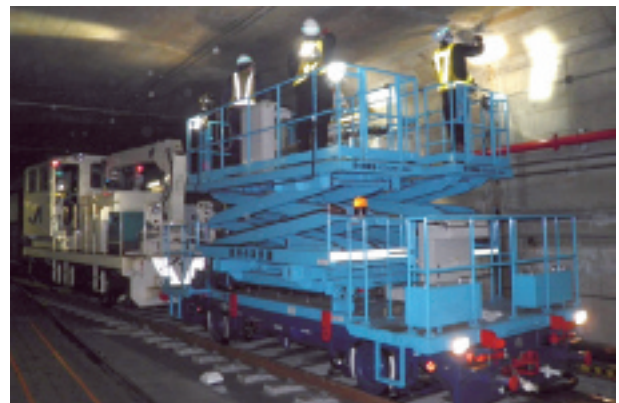
図-1 高所作業車の全景
