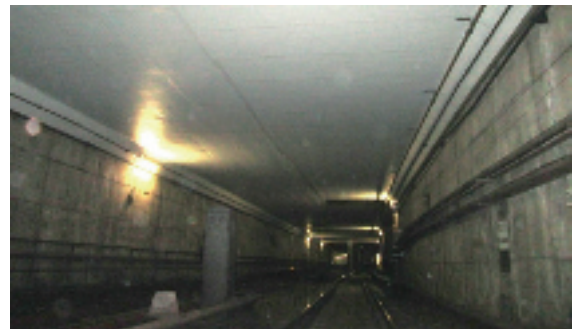
箱型トンネルにおける予防維持補修完了状況
