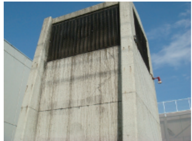
写真6 琴似駅中間換気塔
