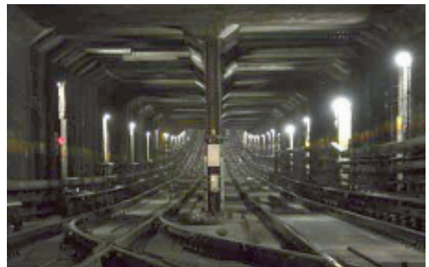
図-8 銀座線トンネル内
