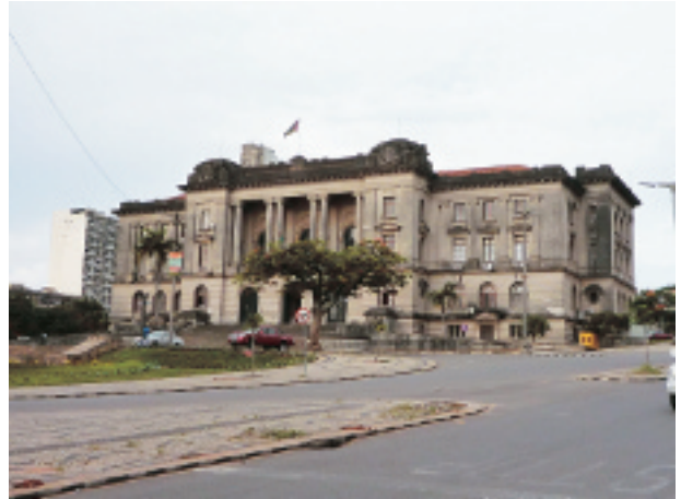
写真-22 マプト市庁舎は、1945年にポルトガル植民官庁舎として建てられた植民地風の建築である。(2012年12月6日)
