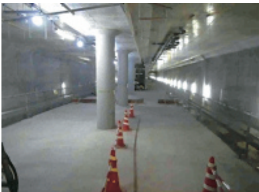
西公園工区の工事状況
