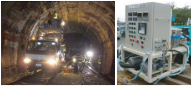
写真-1 Tn-p施工状況とTn-p注入機
