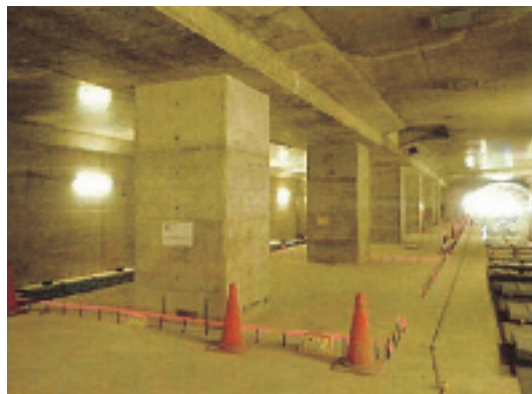
連坊工区の工事状況
