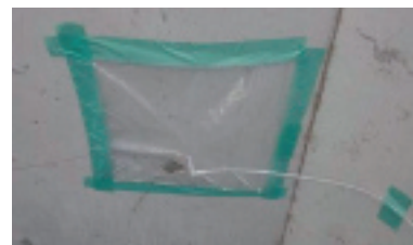
写真-3 ビニファネル設置状況
