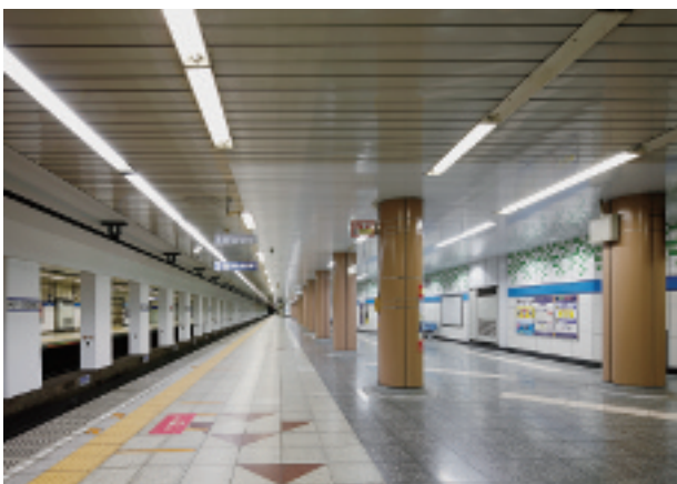
東西線門前仲町駅施工後
