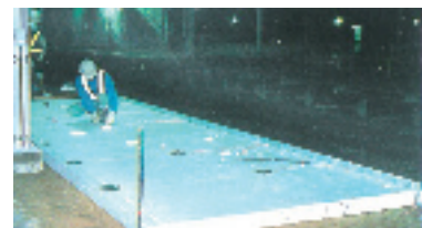
写真-2 EPS施工状況（ホーム嵩上げ）
