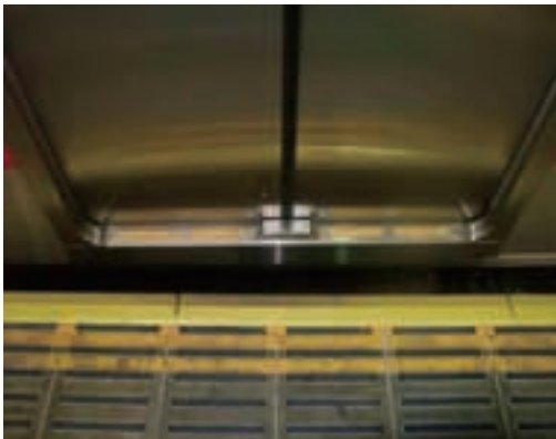
写真4 転落防止ゴム
