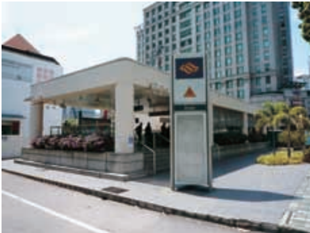
写真-22 SMRT社の東西線ブギス (EW12) 駅 (地下駅) の入口には、駅名案内標が立っている。(南を見る。2011年11月19日)
