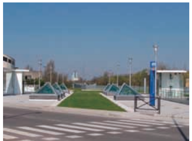
ピラミッド型の地上採光口
