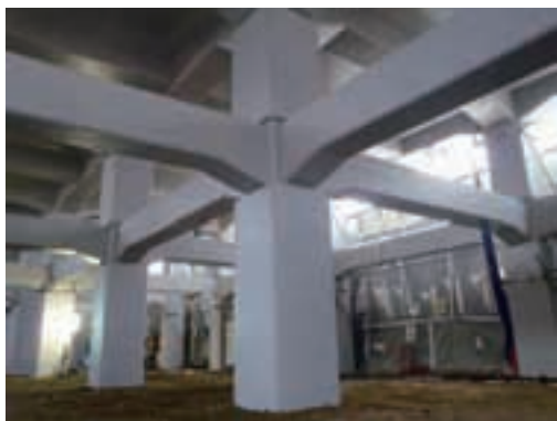
写真6 耐震補強された高架橋
