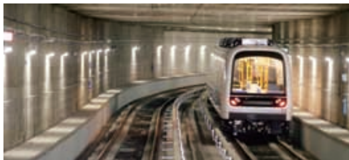
壁両側に避難通路がある
