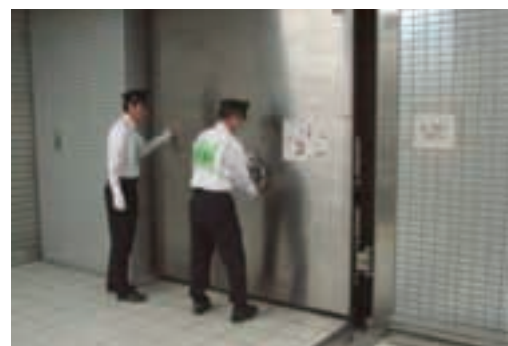
止水鉄扉の閉扉
