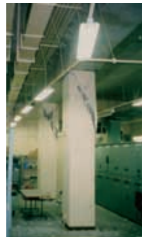
上沢駅地下1階の被災状況
