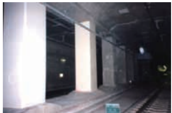
図2 耐震補強後の中柱
