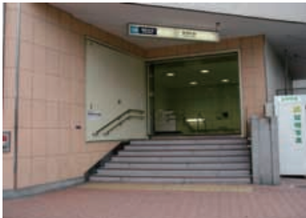
図6 駅出入口の嵩上げと防水扉
