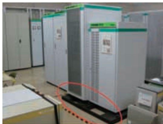
図9 運行管理コンピュータ免震装置
