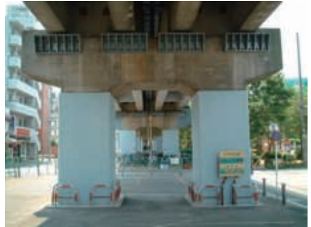
図1 高架橋柱の耐震補強
