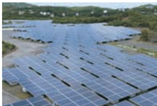
メガソーラー発電所（志摩市）
