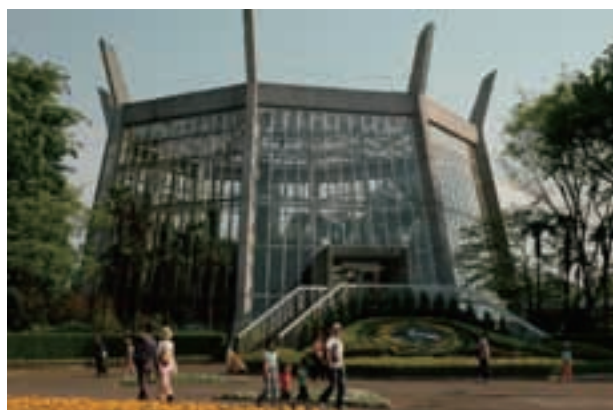
川口市立グリーンセンター 大温室
