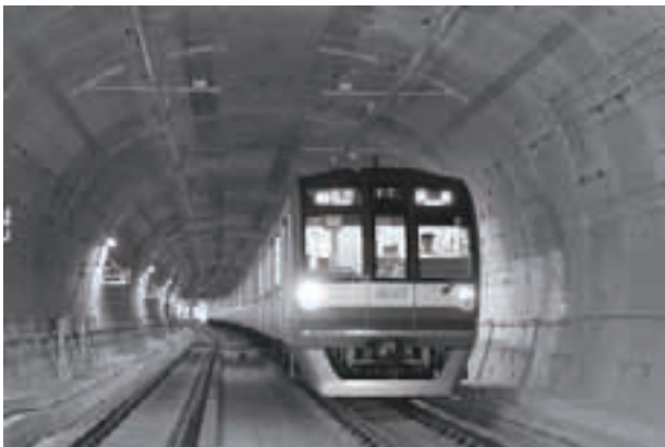
写真-20 複線トンネルの理想形 複合円形シールド（副都心線）
