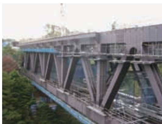
竜の口橋りょうの架橋工事 （動物公園駅～青葉山駅間）
