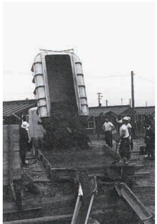
写真-3 丸ノ内線池袋付近の生コンクリート打設
