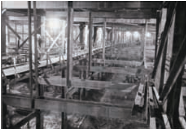
写真-6 全面的に鋼製支保工を使用した開削工事（日比谷線）
