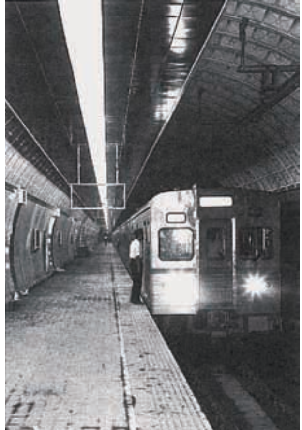
写真-10 日本初のシールド駅となった東西線木場駅
