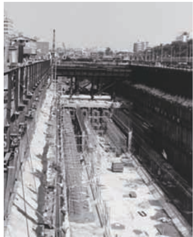
写真-12 グランドアンカーによる全断面掘削（有楽町線市ヶ谷付近）
