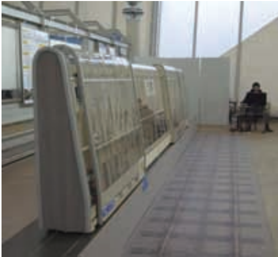
図7 ホーム端ぎりぎりに設置される“どこでも柵”
