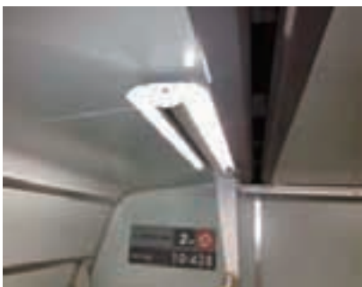
客室内に採用するLED照明(新宿線)
