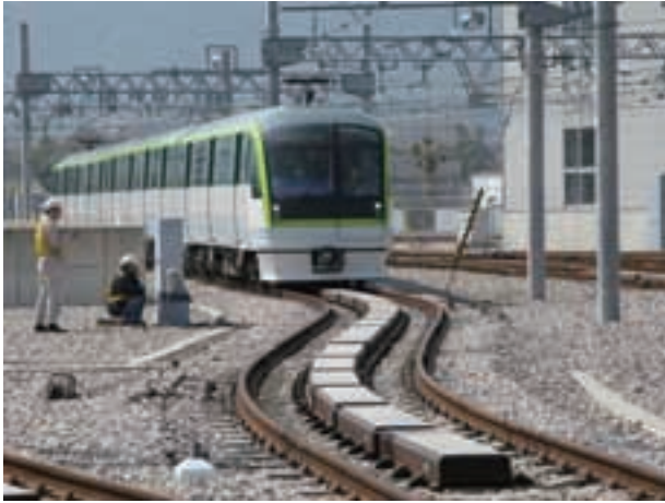
写真-5 橋本車両基地における試験
