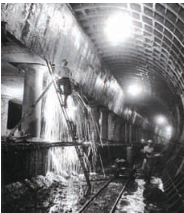
写真-13 切り抜け工事の完了した新御茶ノ水駅（千代田線）
