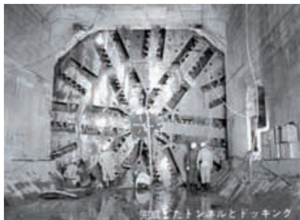
写真-14 到達した大断面泥水加圧式シールド（有楽町線小竹向原付近）
