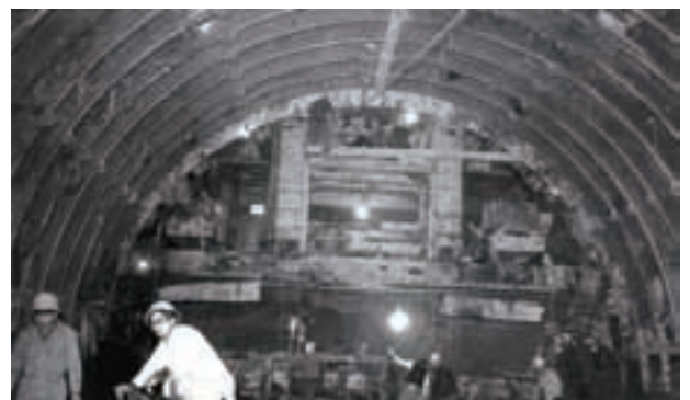
写真-8 掘進中のルーフシールド（丸ノ内線国会議事堂前付近）
