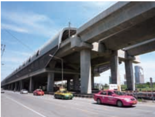
写真-46 空港連絡鉄道 (SARL) のマッカサン駅。2面4線の高架駅である。(西を見る。2011年8月6日)
