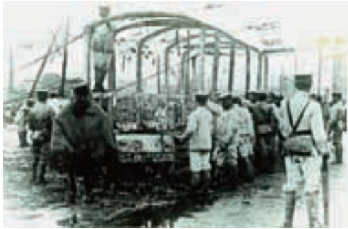
焼失した車両を撤去する陸軍工兵隊
