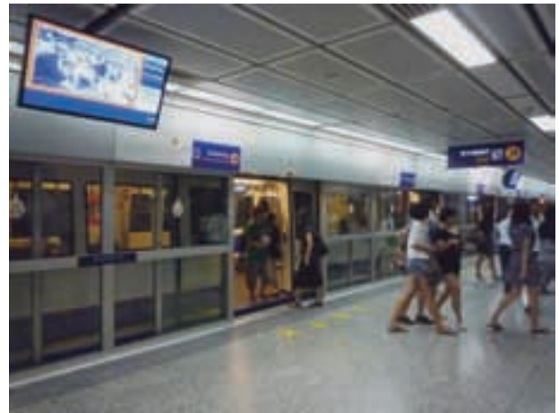
写真-36 MRT(ブルーライン)の地下駅にはすべてホーム=ドアが設置されている。(シーロム駅。2011年8月6日)
