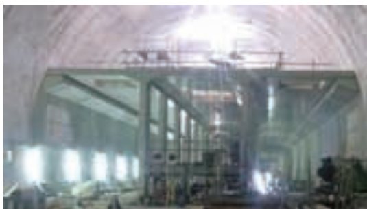
駅舎階構築工事（青葉山駅）
