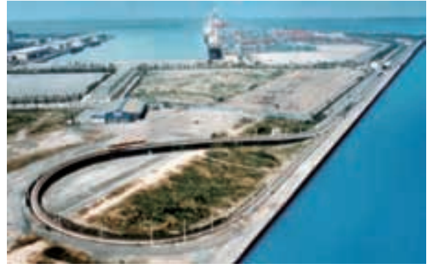
写真-1 大阪南港試験線
