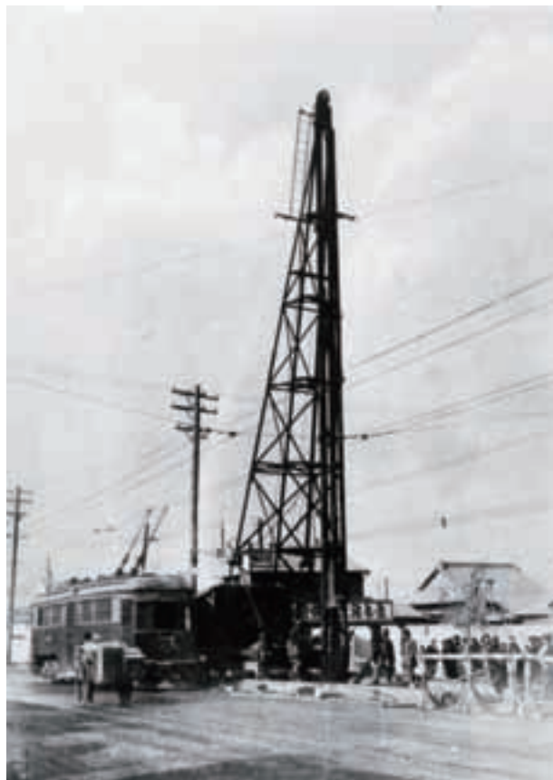
写真-1 戦前期の杭打ち風景（銀座線）
