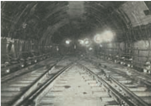
写真-2 山岳工法で施工した民地下のトンネル（銀座線神田付近）
