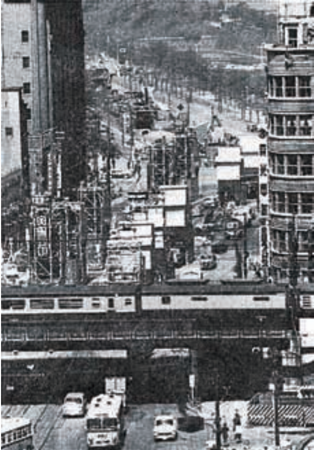
写真-9 日比谷付近の潜函工事（日比谷線）
