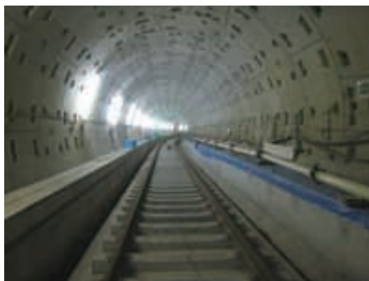
シールドトンネル （六丁の目駅～荒井駅間）
