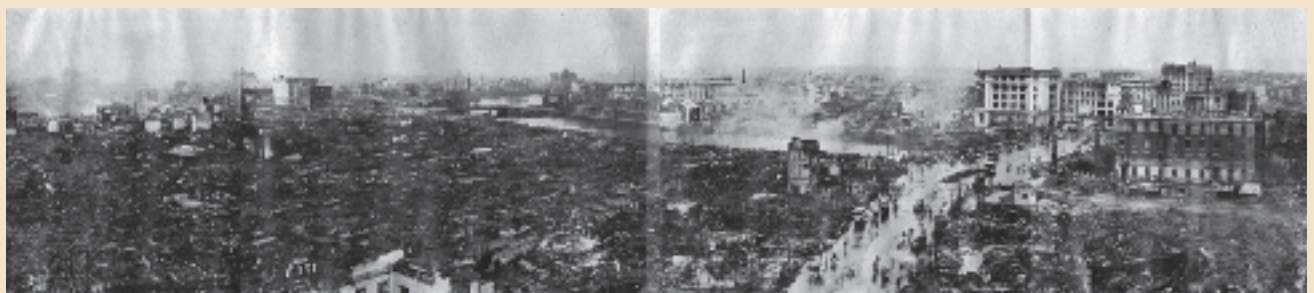
写真－1－4 京橋の第一相互ビルディング屋上より見た日本橋及び神田方面の惨状
