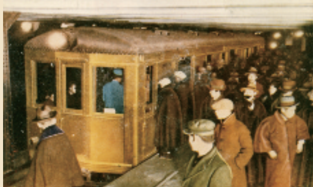
写真-1-5 地下鉄上野～浅草間開業（絵葉書より）
