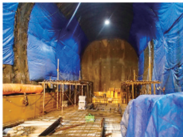
躯体構築中のナトム部
