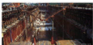
市ヶ谷付近工事
