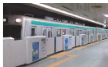
烏丸御池駅の可動式ホーム柵
