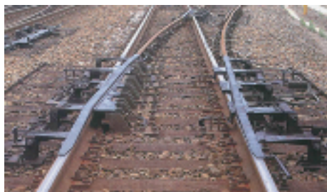
写真-3 可動式横取り装置
