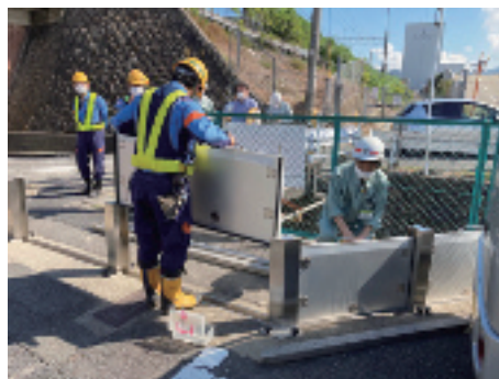
止水板設置訓練の様子
