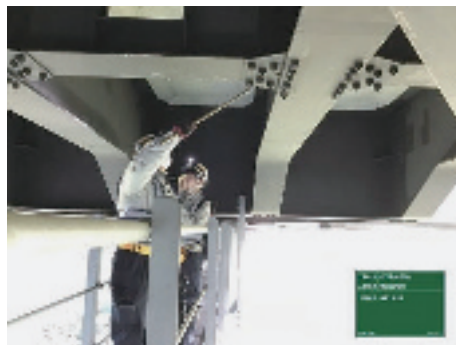
橋りょう検査
