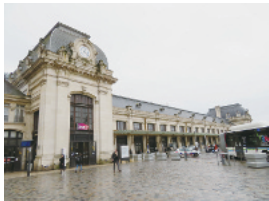
写真－31 1898年に完成したボルドーのサン＝ジャン駅は重厚感のある駅舎である。駅前で路面電車と結節している。（南を見る。2020年1月30日）
