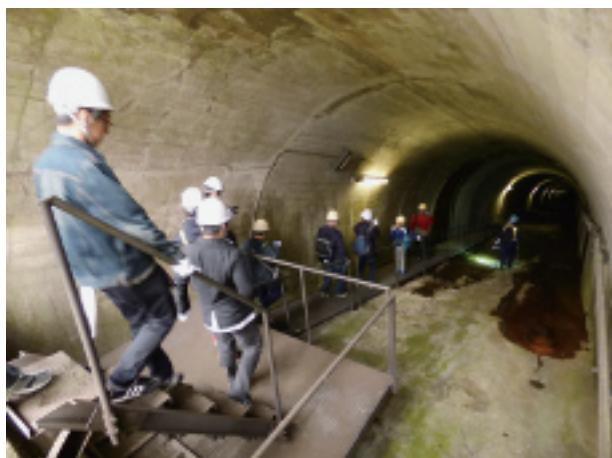
鍋立山トンネルの斜坑を下りるツアー参加者。山岳トンネルでは建設時の斜坑が、貫通後も資材搬入用などに活用されています。
