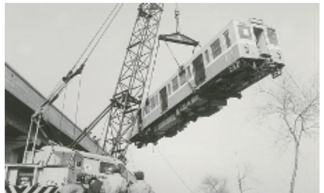
クレーンで高架橋上に電車を吊り上げる
