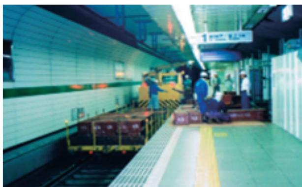
図4 モーターカーでの資材搬入
