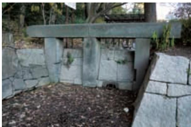
大洗堰の取水口の流量調節施設の遺構
