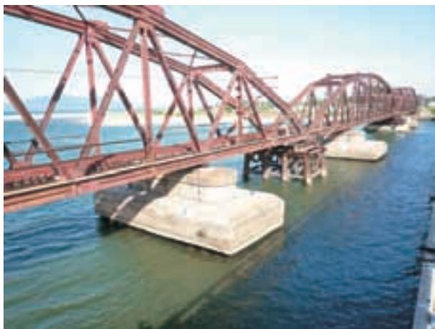
写真-53 南北統一鉄道のダナン駅の北にあるナムオ一橋（フランス式櫛桁4連）。15年前にもこの橋を調査した。（サイゴン方を見る。2008年8月17日）
