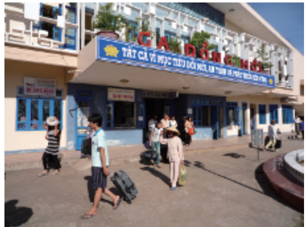
写真-40 線路側から見たドンホイ駅の駅舎。サイゴン駅行きのSE 3列車に乗車する旅客がホームに集まってくる。ノンラー（円錐形の藁帽子）をかぶったベトナム女性は南部に多い。（北西を見る。2008年8月17日）
