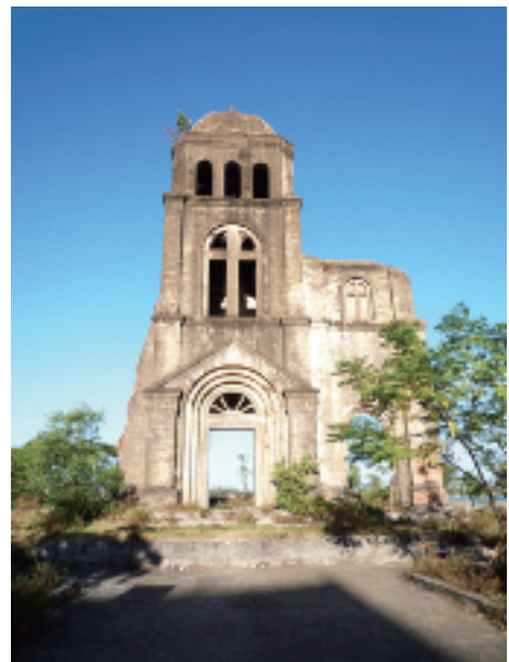
写真-39 ドンホイのニャットレ川河畔には、ベトナム戦争時の北爆で破壊された教会がそのまま残っている。（東を見る。2008年8月16日）
