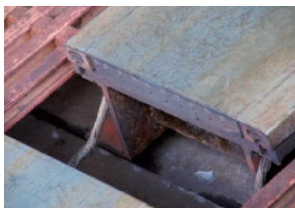
リアクションプレート断面 （アルミキャップと鉄積層：10分割）
