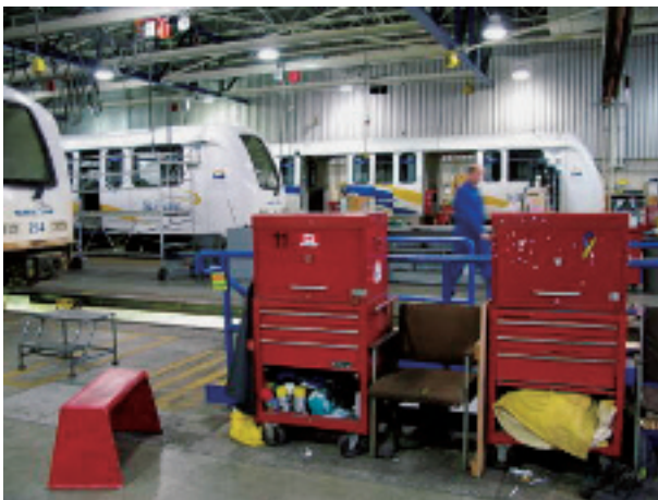
基地設備（点検線）
