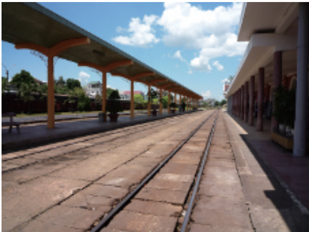
写真-47 フエ駅の構内は線間が舗装されているので、低床ホーム間の移動が楽である。(ハノイ方を見る。2008年8月17日)
