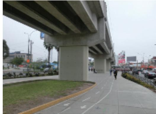
写真-42 アンガモス駅近くの高架橋。4主桁が使用されている。(2015年11月22日)
