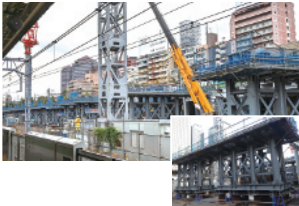
仮設鋼製構台の構築状況
