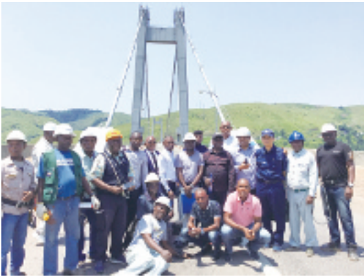
写真-1 日本の経済・技術協力により1983年5月に開通したマタディ橋は、日本の技術移転によりコンゴ人技術者たちが点検・保守を行っており、完成から40年たつが良好な状態に保たれている。右から3人目が筆者。(2020年2月11日)
