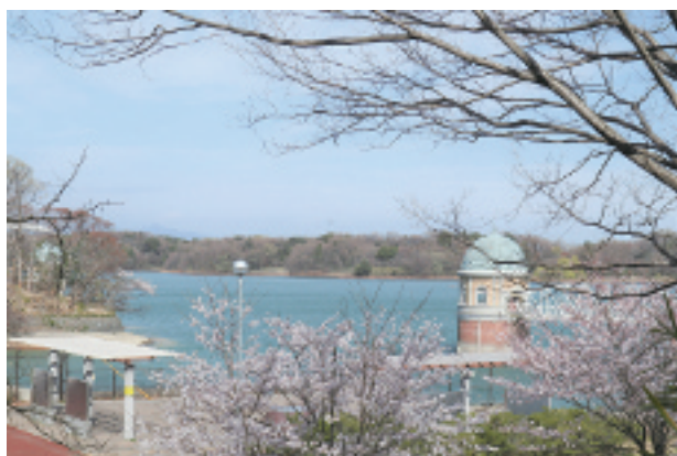
都立狭山公園から見た多摩湖取水塔
