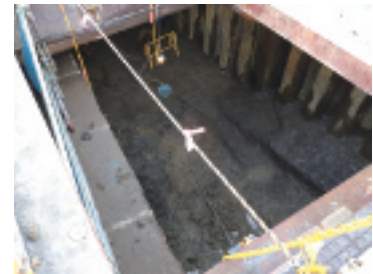
トンネル周りの掘削状況
