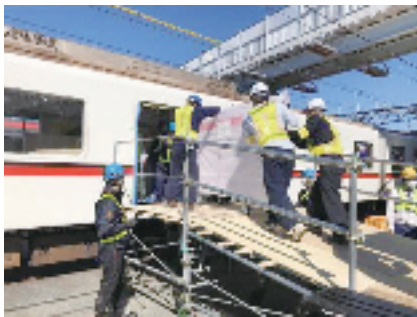
列車への積み込み（車両基地）
