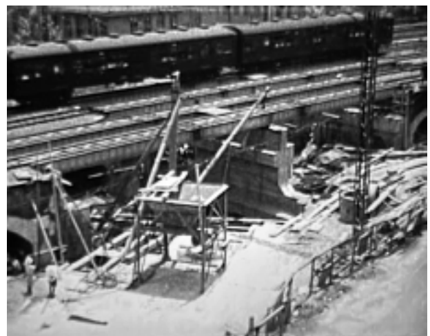
交差部工事の様子・第四有楽町高架橋
