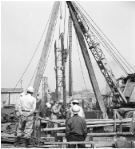
鉄筋かご吊り込み作業
