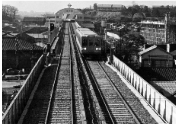
バラスト道床 後樂園駅付近
