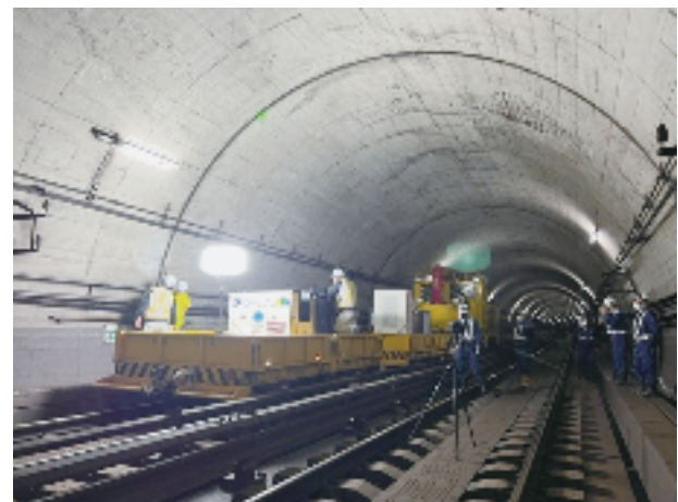
レーザーによるトンネル壁面の打音検査
