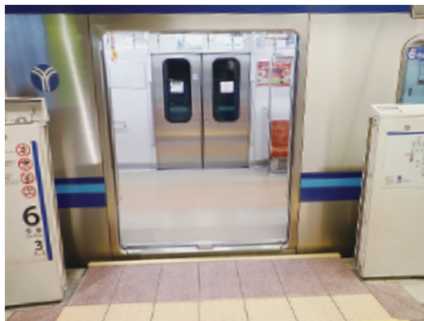
ホームと車両の段差・隙間（施工後・上大岡駅）
