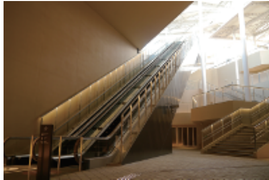
箕面船場阪大前駅構外エスカレーター
