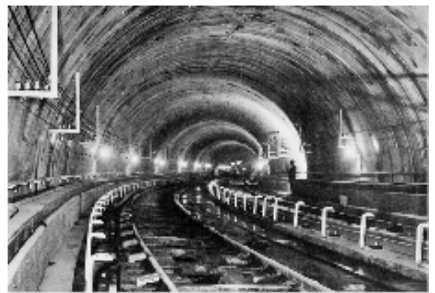
完成した国会議事堂附近の隧道（トンネル）
