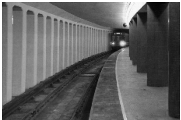
コンクリート道床 御茶ノ水駅
