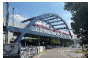
名鉄河和線立体交差
