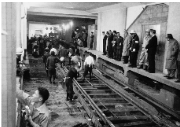
池袋駅改良工事風景
