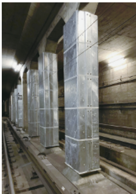
トンネル部の耐震補強工事
