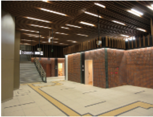
箕面萱野駅南駅舎
