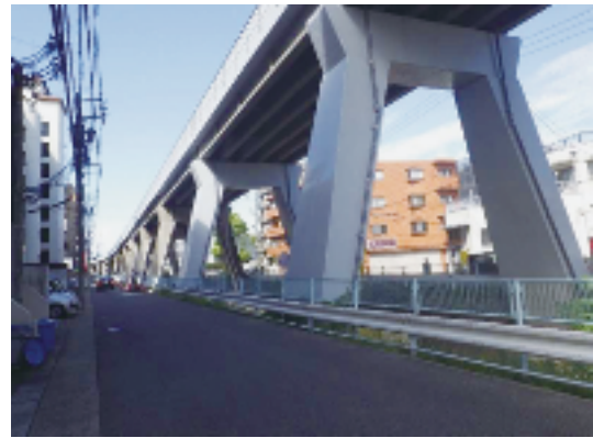
耐震補強を実施した橋脚
