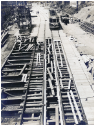
御茶ノ水駅附近で都電の線路を下請けしながらの工事
