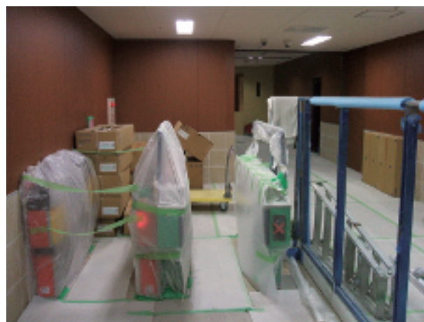
地下2階改札口設置工事
