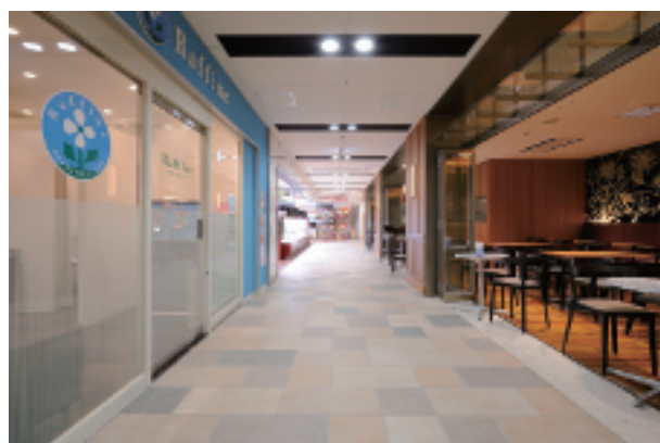
地下2階完成写真
