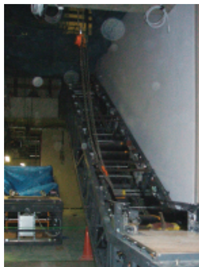
エスカレーター設置中
