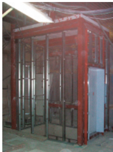
エレベーターシャフト築造中
