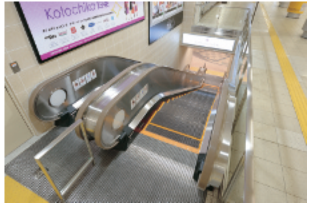
新設エスカレーター
