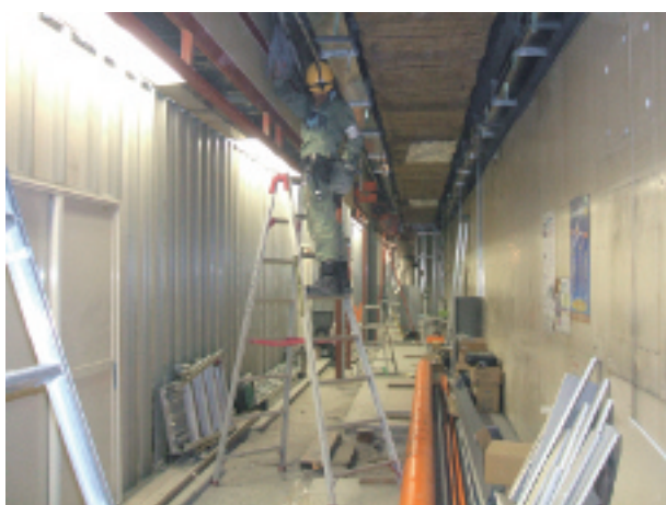
地下1階区画工事
