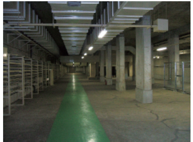
工事着手前の地下2階
