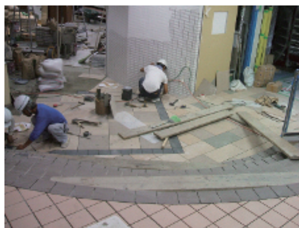
地下2階階段下部タイル工事
