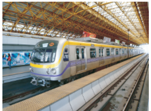
写真-37 アラネタ=センター=クバオ駅に停車する2号線の電車。(南西を見る。2009年11月15日)
