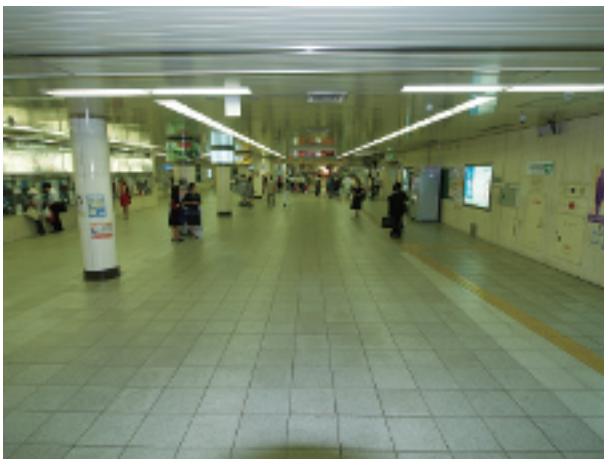
工事着手前の地下1階
