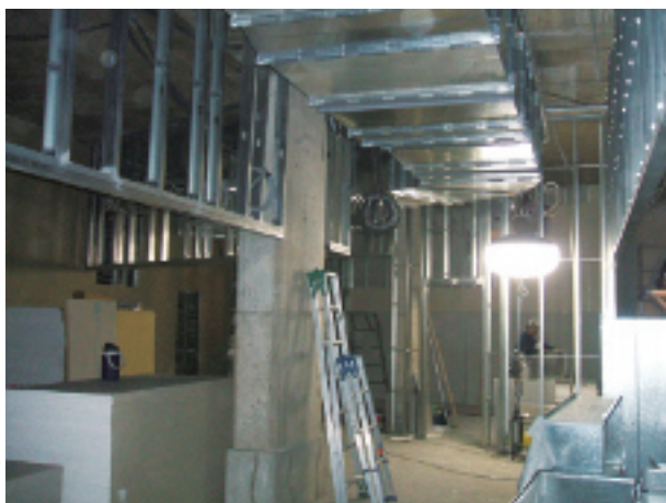
地下2階区画工事
