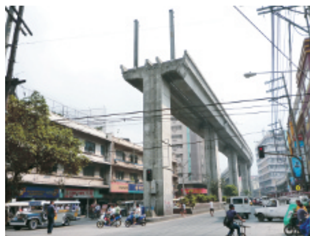
写真－25 レクト通りの中央分離帯の上に建設された2号線の高架橋は、ここで途切れている。（東を見る。2009年11月14日）
