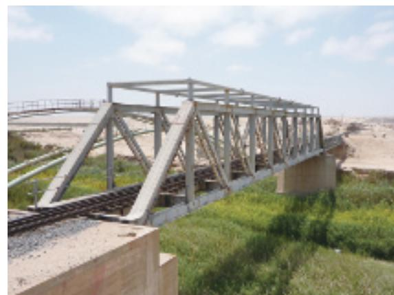
写真-73 C34号道路沿いのトランスナミブ鉄道のトラス橋梁。少し錆はあるが比較的状態はいい。奥に見えるのはパイプライン用のアーチ橋。（2013年1月27日）
