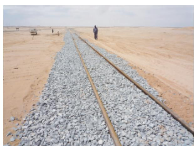
写真-71 写真-70近くの線路では、バラストとコンクリート枕木など軌道材料の交換が行なわれている。(2013年1月27日)
