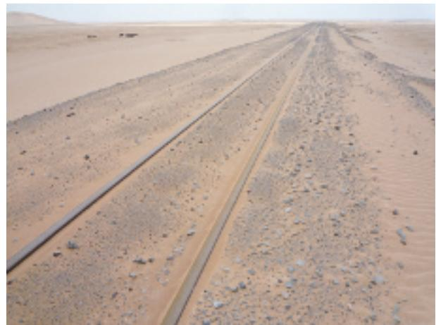
写真-70 ウォルビス=ベイから東に向かうC14号道路沿いにある線路は、砂丘が近いため砂に埋まり、レール踏面しか見えない。(2013年1月27日)
