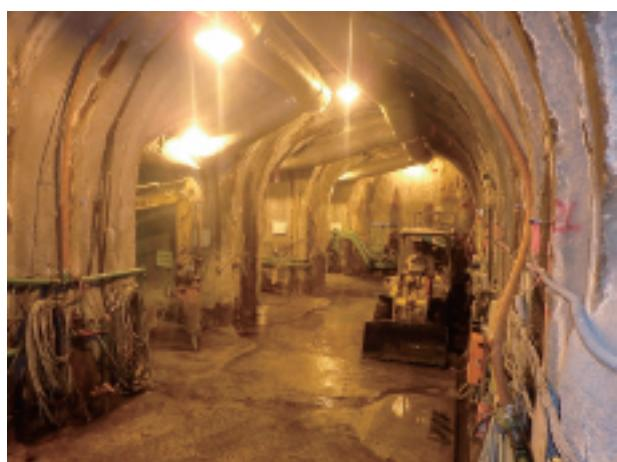
図-10 導坑掘削の様子
