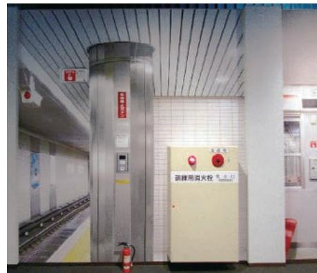
写真5 非常停止合図装置・屋内消火栓
