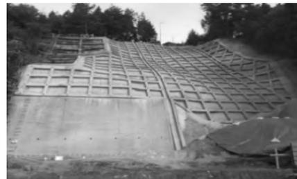
例：斜面の補強（鉄道に隣接する斜面を補強することにより、線路への土砂流入等の被害を防止）
