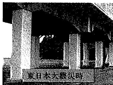
【高架橋の補強】
