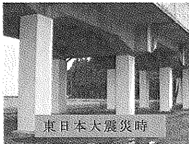
【高架橋の補強】
