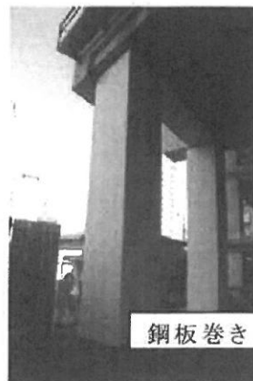
【高架橋の補強】
