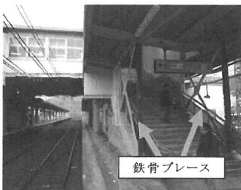
【橋上駅の補強】
