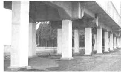
鋼板巻きによる 高架橋の耐震補強
