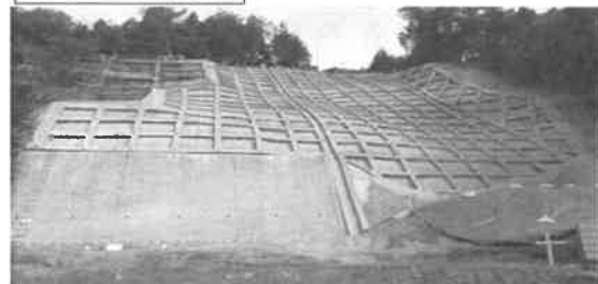
コンクリート枠による斜面の補強
