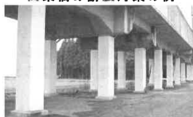
鋼板巻きによる 高架橋の耐震補強
