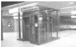
エレベーター
