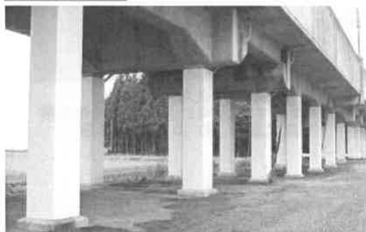
鋼板巻きによる高架橋の耐震補強
