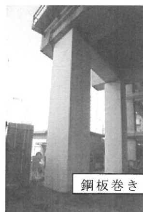
【高架橋の補強】
