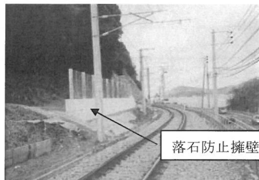
【落石防止擁壁の一例】
