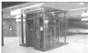
エレベーター
