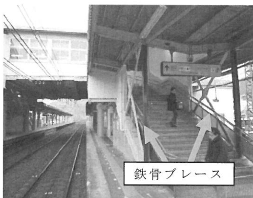
【橋上駅の補強】
