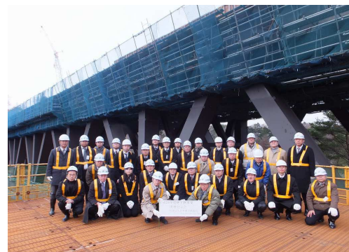
～竜の口橋梁、八木山トンネル工区～
