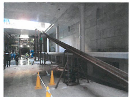
レール投入状況
