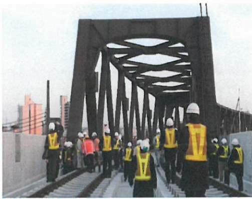
写真) 城東貨物線接続部付近の神崎川橋りょう
