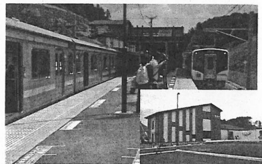
仙石線 復旧後:野蒜駅
