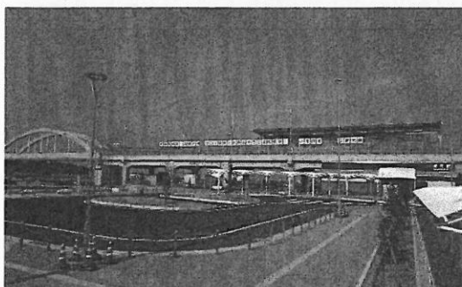
常磐線 復旧後:坂元駅
