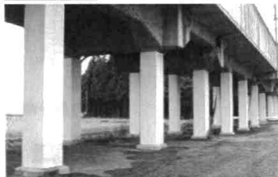
鋼板巻きによる高架橋の耐震対策
