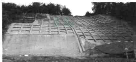
コンクリート枠による斜面の補強
