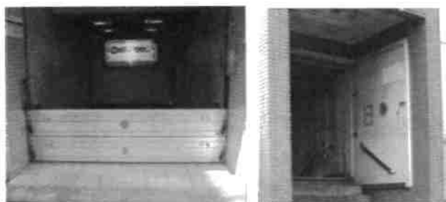
止水板・防水扉の整備
