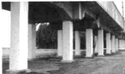
鋼板巻きによる高架橋の耐震対策
