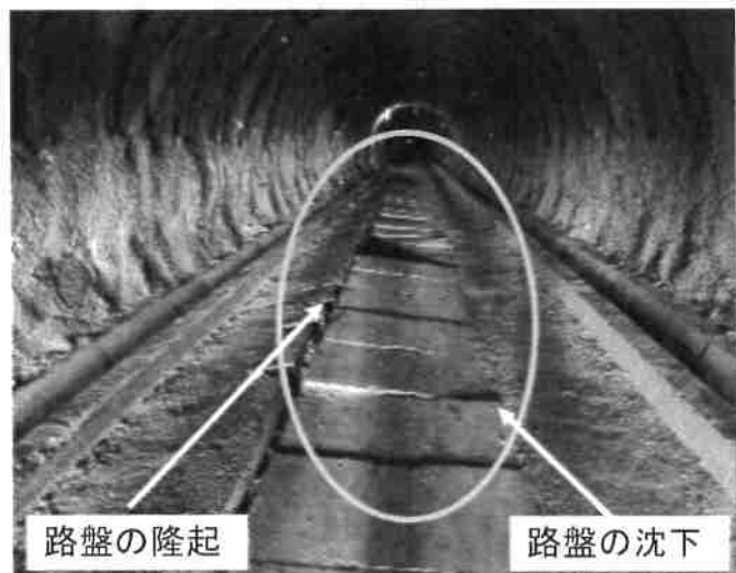
トンネル（先進導坑）の変状
