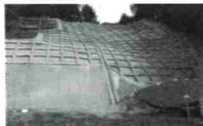
斜面の補強
