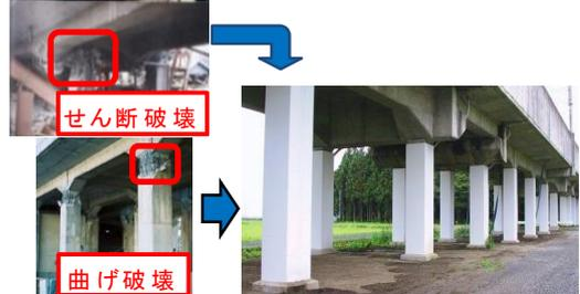
鋼板巻きによる高架橋の耐震補強
