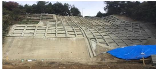
コンクリート枠による斜面の補強
